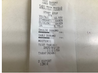
Elektrik donanımı/Pano, Akü > Test Sonucu
