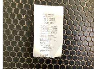
Elektrik donanımı/Pano, Akü > Test Sonucu
